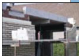
Si des charges autres que celles admises sont appliquées sur le linteau, il est indispensable d'avoir recours aux services d'un architecte ou d'un ingénieur qui prescrira, le cas échéant, une poutrelle mécanique ou une **poutre** en béton armé dans la section nécessaire.
