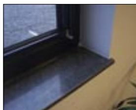
Une autre utilisation courante de la pierre (marbres et granits principalement) est la pose de tablettes intérieures de fenêtre. Polies sur toutes les faces, et en 2 ou 3 cm d'épaisseur, elles existent également sur mesure ou en dimensions standards.
