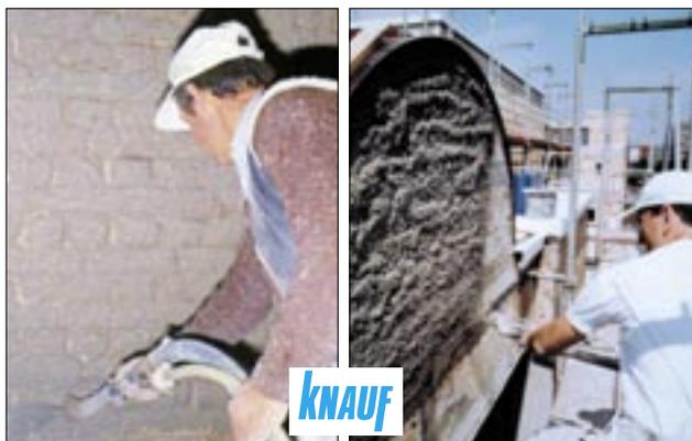
**2.** Une seconde couche (*corps d'enduit*), de  $\pm 10$  à 12 mm, composé d'un cimentage à base de :
