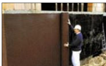
**!** Utilisez les attaches et profilés spéciaux de manière à garantir l'étanchéité de votre fixation !!
